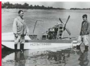
Внедорожное транспортное средство группы разработчиков, в котором использовался принцип скольжения для создания универсальных глиссирующих (от фр. glisser — скользить) аппаратов, предназначенных для движения по воде, снегу, льду, болоту, мелким водоемам и зарослям.
