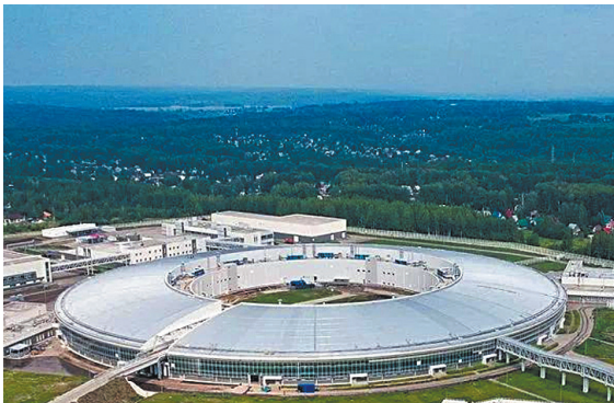
«СКИФ» представляет собой комплекс из 34 зданий, расположенный на территории площадью 30 гектаров.
