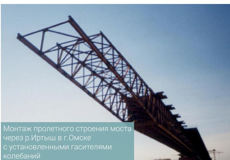
Монтаж пролетного строения моста через р.Иртыш в г.Омске с установленными гасителями колебаний
