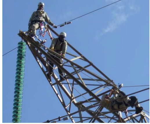
Рисунок 1.18 – Увеличение расстояний приближения за счёт изменения траектории доставки электромонтёра к узлу подвески («метод 45°» [1])
