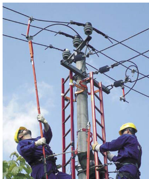
Рисунок 1.1– Ремонтные работы на линиях средних классов напряжения
