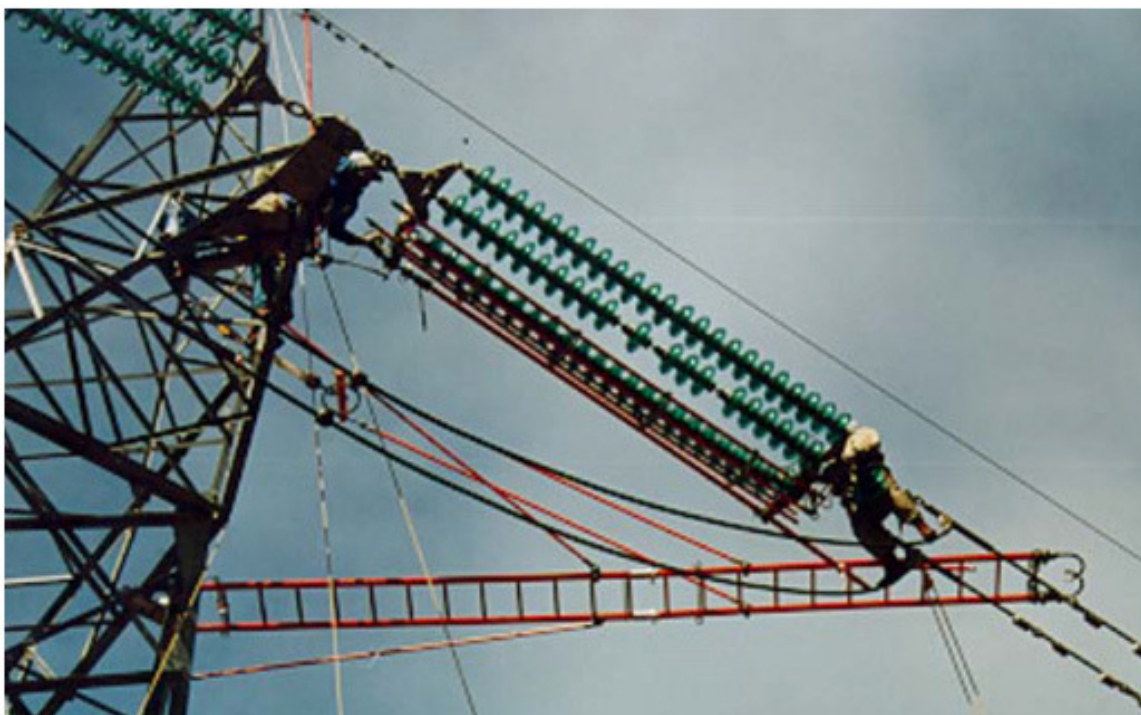
Рисунок 1.3– Замена натяжной гирлянды изоляторов на линии 400 кВ с перемещением мон­тёра по горизонтальной изолирующей лестнице
