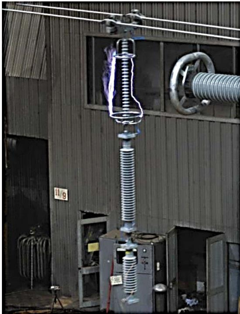
а) испытания напряжением промышленной частоты. Общий вид объекта испытаний
