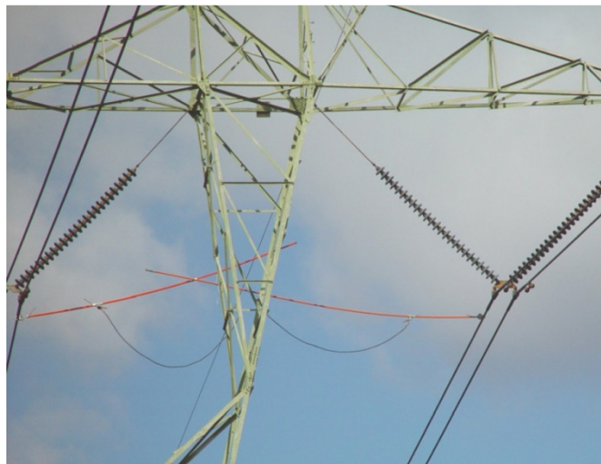
Рисунок 1.20– Защитные искровые промежутки на линии 500 кВ
