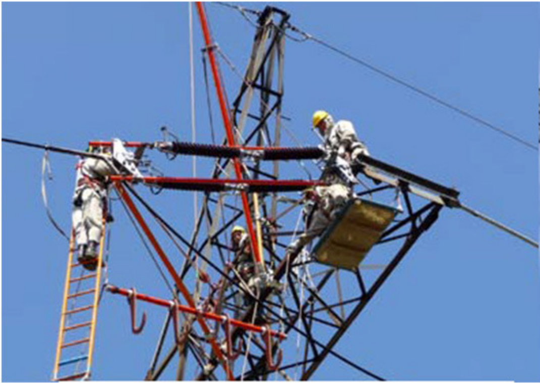
Рисунок 1.4— Замена натяжных гирлянд изоляторов на линии 400 кВ с перемещением монтажника по вертикальной изолирующей лестнице
