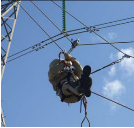
Рисунок 1.18 – Увеличение расстояний приближения за счёт изменения траектории доставки электромонтёра к узлу подвески («метод 45°» [1])
