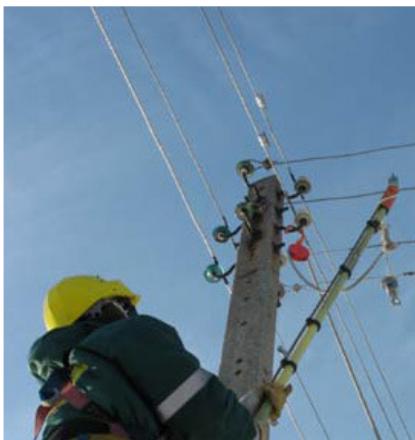
Рисунок 1.1– Ремонтные работы на линиях средних классов напряжения
