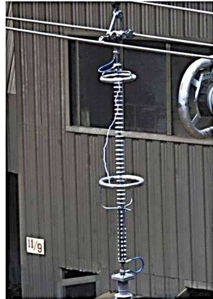
г) испытания напряжением коммутационного импульса. Вид воздушного промежутка
