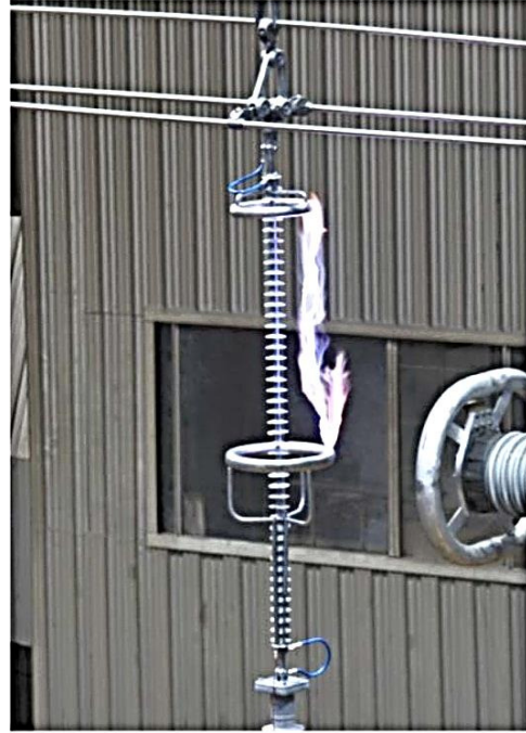
б) испытания напряжением промышленной частоты. Вид воздушного промежутка
