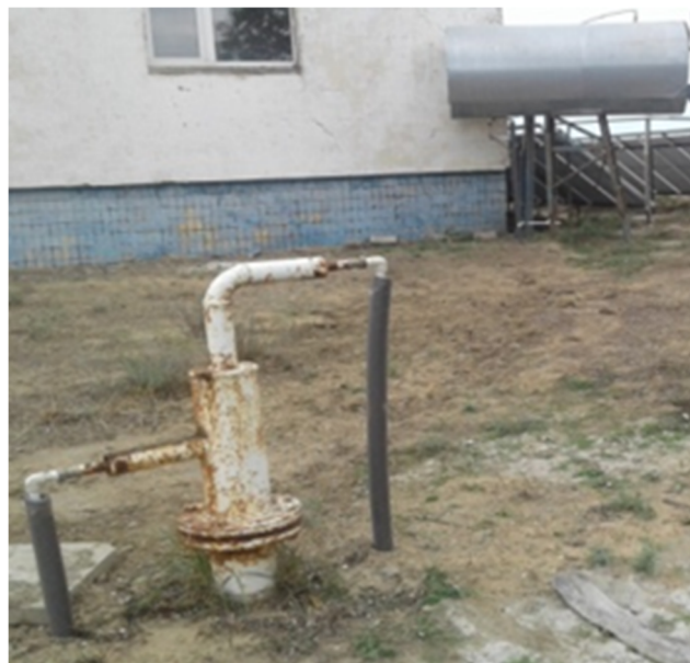
Рисунок 4.4 – Оголовок скважины-теплообменника
