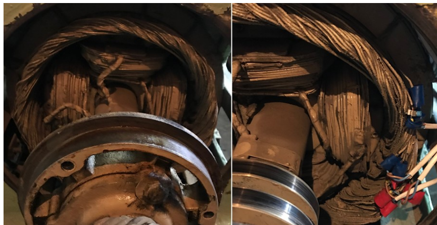
Рисунок 4.4 - Подключение ответвлений к проводникам обмотки статора генератора МСА-72/4А
