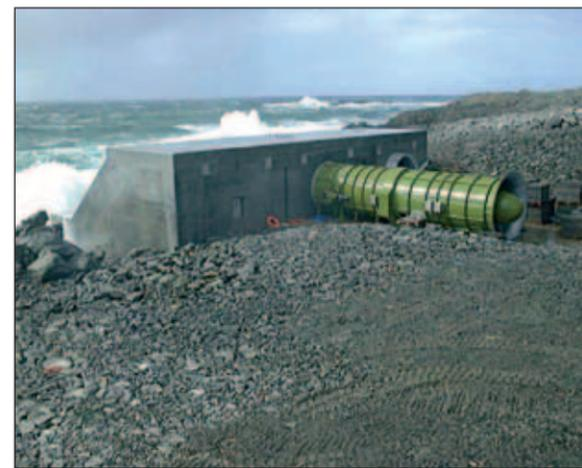
Волновая электростанция, преобразующая энергию волн с помощью технологии колеблющегося столба
