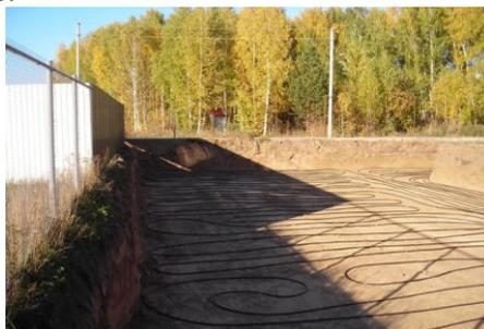
Рисунок 5 – Горизонтальный низкопотенциальный контур
