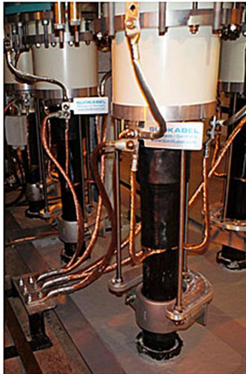
Рисунок 2.4 – Совместное заземление экрана кабельной линии
