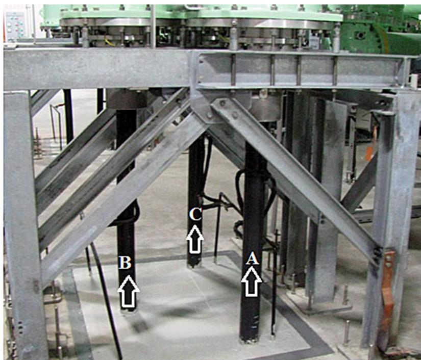
Рисунок 3.12 – Места установки датчиков ЧР на кабельном вводе для проведения синхронных измерений по трём фазам
