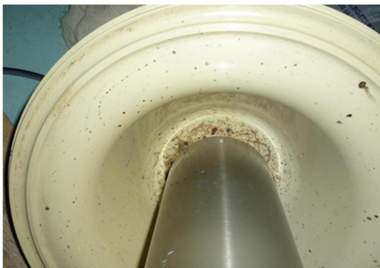
Рисунок 1.17 – Внешний вид опорного изолятора в КРУЭ 330 кВ
