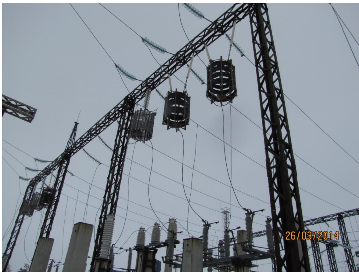
Рисунок 6.1 - ЧЗУ на портале подстанции «Сугмутская»
